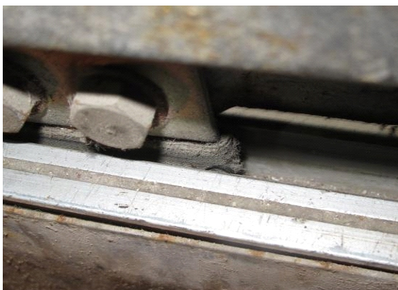
图9 门脚滑块磨损严重
