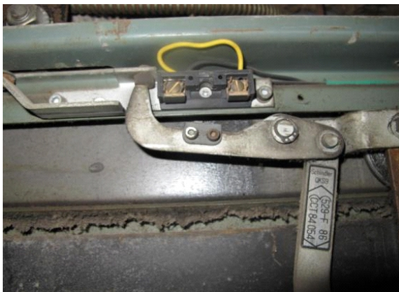
图26 轿门左侧主门锁短接
