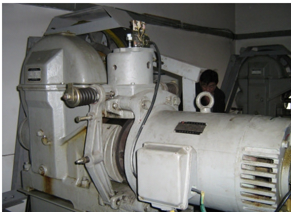
图23 制动器机械部分未分两组装置
