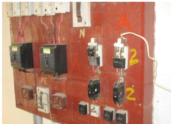
图20 非标准的总电源进线系统
